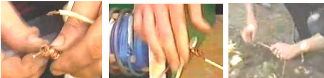
et où nécessaire, serrer la torsion avec une paire de pinces:
