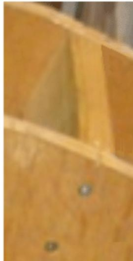
Persönlich würde Ich mag die Schrauben versetzt sein, so dass weder auf der Mittellinie der Planke, wie das ist die schwächste Anordnung, und so schlage ich vor, dass die beiden Schrauben ein Drittel der Art und Weise, von der Dielenkante wie positioniert bietet eine stärkere Verbindung mit den Schrauben 13 mm voneinander und nicht die Betonung der Holz along einer Ebene.
