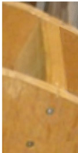
Personnellement, je voudrais que les vis soient compensées de sorte que ni est sur la ligne de centre de la planche que celle est l'arrangement le plus faible, et donc je suggérer que les deux vis sont positionnés un tiers du chemin à partir du bord de la planche que celle donne un lien plus fort avec les vis de 13 mm d'intervalle et non soulignant le bois along un plan.
