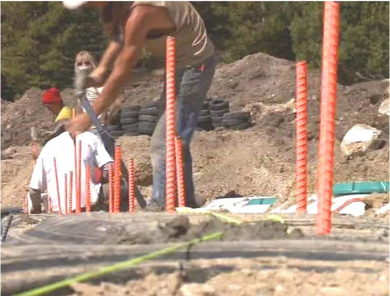
Die Stahlstäbe, die "Bewehrungsstäbe" genannt werden, werden in die Wände getrieben und auf die exakte Höhe positioniert, und ein verstärkter Betonring wird um die Oberseite der Wände herum gegossen, um der Struktur insgesamt Festigkeit zu verleihen, bevor die schweren Baumstämme eingesetzt werden.
