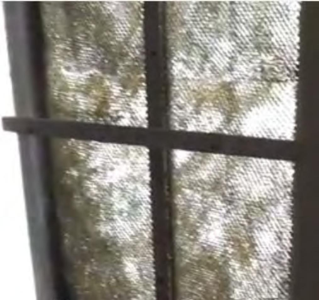
Die Pads werden durch Wassertropfen auf den oberen Rand des Fensters durch eine kleine Pumpe in einer großen Kunststoff-Box mit Wasser gefüllt unter Wasser gepumpt feucht gehalten:
